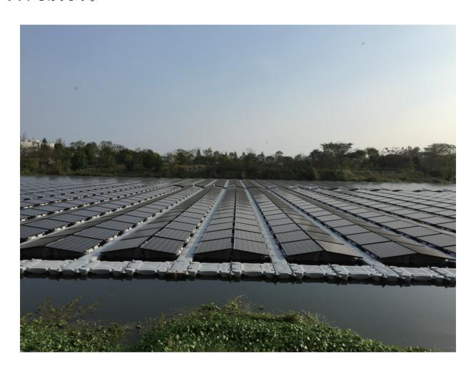
【設備容量】 5,130kW(第1:4,000kW 第2:1,130kW)
