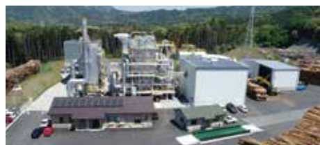
ふくおか木質バイオマス発電所 5,700kW (2020年5月運転開始)
