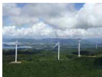
◎串間風力発電所 64,800kW (2020年10月運転開始)
