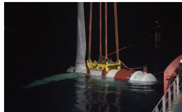
海底への設置作業
