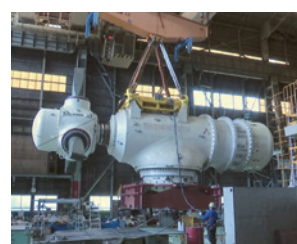
改造中の潮流発電機
