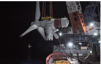
クレーンでの運搬の様子
