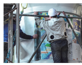
イラストの貼り付け作業
