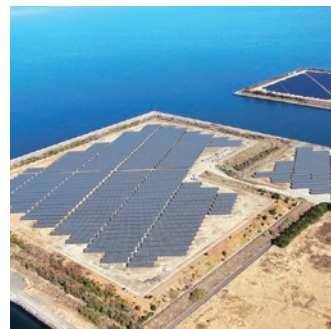
大村メガソーラー第1発電所
