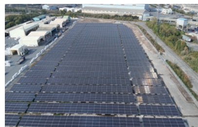
苅田ソーラー発電所
