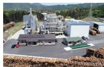
ふくおか木質バイオマス発電所
