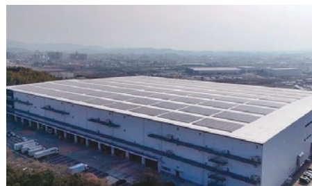
粕屋ソーラー発電所
