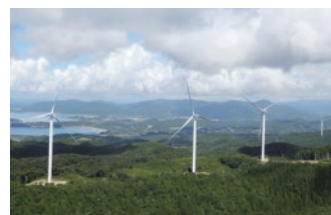
串間風力発電所
