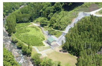
鴨猪水力発電所
