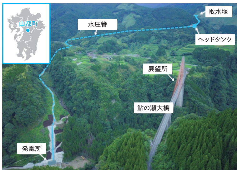
発電所の全景
