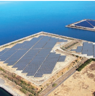
大村メガソーラー第1発電所
