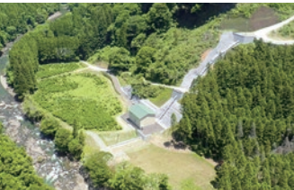
鴨猪水力発電所
