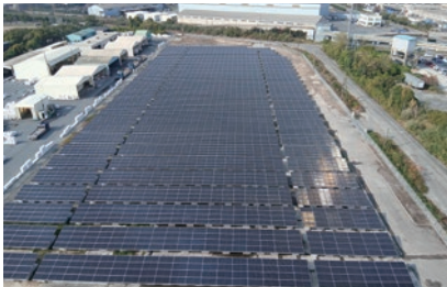
苅田ソーラー発電所
