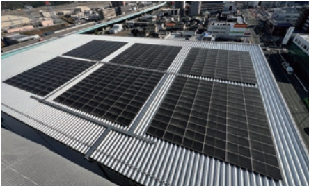
東那珂ソーラー発電所
