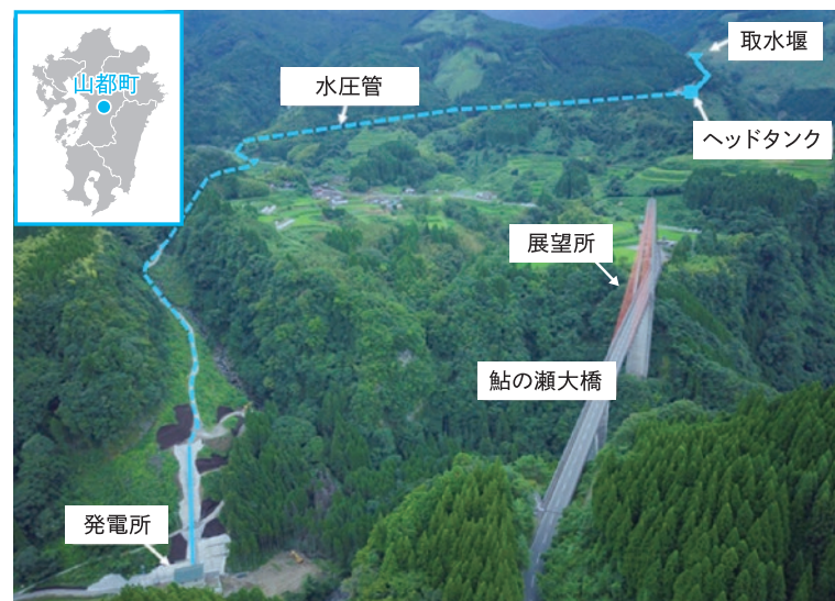
発電所の全景
