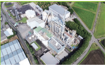
みやざきバイオマスリサイクル第2発電所 11,350kW (2026年5月運転開始) 燃料に家畜排泄物(鶏ふん)を使用
