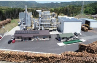
ふくおか木質バイオマス発電所
