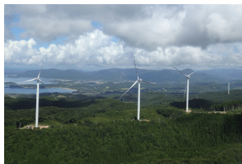
◎串間風力発電所
