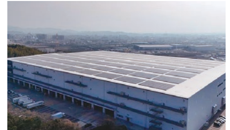
粕屋ソーラー発電所
