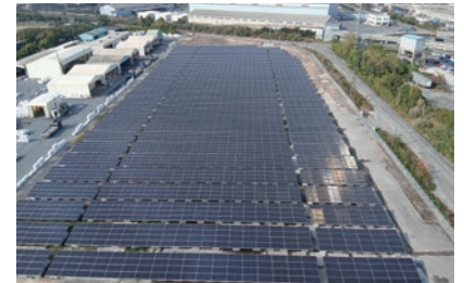
苅田ソーラー発電所
