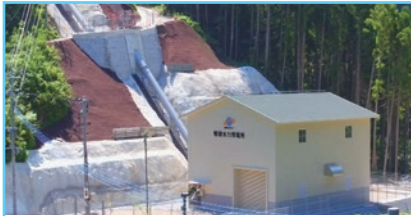
鴨猪水力発電所 1,990kW (2018年9月運転開始) 地域のかんがい用水路と未利用落差を有効活用
