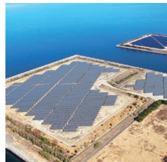
大村メガソーラー第1発電所
