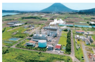
山川発電所[鹿児島] 30,000kW 運転開始時期/1995年
