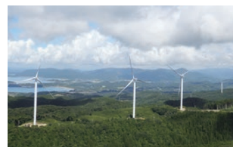
串間風力発電所
