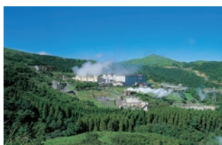
八丁原発電所[大分] 110,000kW 運転開始時期/1号機1977年 2号機1990年
