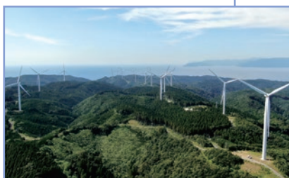
串間風力発電所 64,800kW (2020年10月運転開始) 風車(2,850kW)23基設置
