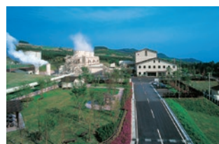
大霧発電所[鹿児島] 30,000kW 運転開始時期/1996年
