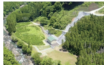
鴨猪水力発電所
