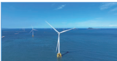
ひびきウインドエナジー(株)提供 北九州響灘洋上ウインドファーム 220,000kW (2026年3月運転開始) 国内最大の洋上風力発電所※完成時点
