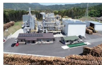
ふくおか木質バイオマス発電所
