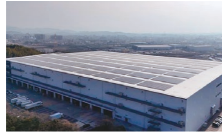
粕屋ソーラー発電所
