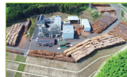
ふくおか木質バイオマス発電所 5,700kW (2020年5月運転開始) 燃料に国産材100%を利用
