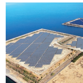
大村メガソーラー第1発電所
