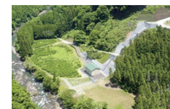
鴨猪水力発電所
