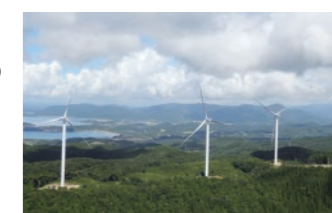
串間風力発電所
