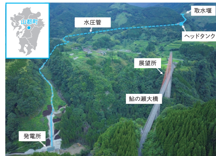
発電所の全景
