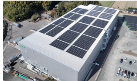
基山ソーラー発電所
