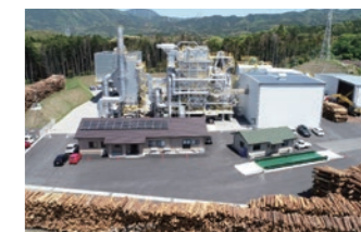
ふくおか木質バイオマス発電所
