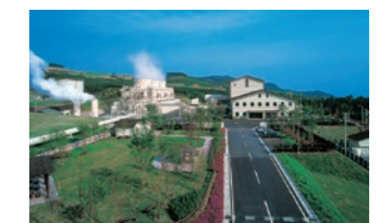
大霧発電所[鹿児島] 30,000kW 運転開始時期/1996年
