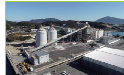
下関バイオマス発電所 74,980kW (2022年2月運転開始) 国内最大級の木質バイオマス発電所
