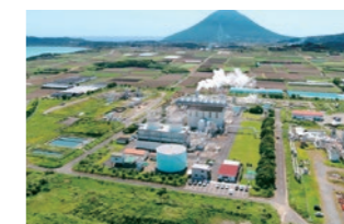
山川発電所[鹿児島] 30,000kW 運転開始時期/1995年
