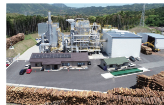
ふくおか木質バイオマス発電所
