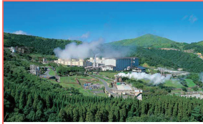
八丁原発電所 110,000kW (1977年6月運転開始) 日本最大の地熱発電所
