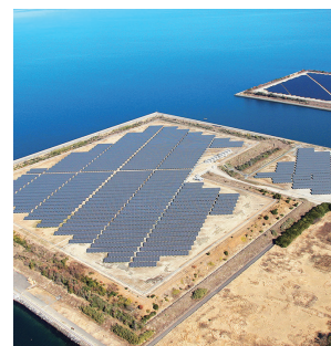
大村メガソーラー第1発電所
