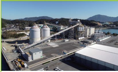
下関バイオマス発電所 74,980kW (2022年2月運転開始) 国内最大級の木質バイオマス発電所
