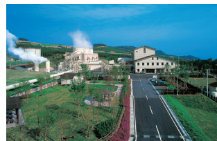
大霧発電所[鹿児島] 30,000kW 運転開始時期/1996年
