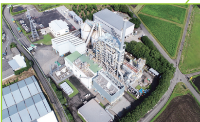
みやざきバイオマスリサイクル発電所 11,350kW (2005年5月運転開始) 燃料に家畜排泄物(鶏ふん)を使用
