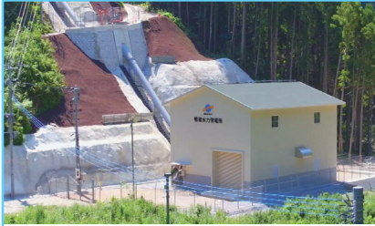
かもしじ 鴨猪水力発電所 1,990kW (2018年9月運転開始) 地域のかんがい用水路と未利用落差を有効活用
