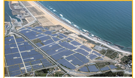
レナトス相馬ソーラーパーク 43,500kW (2017年6月運転開始) 災害被害の土地を有効活用
