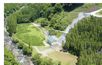
鴨猪水力発電所
