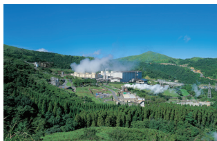
八丁原発電所[大分] 110,000kW 運転開始時期/1号機1977年 2号機1990年
