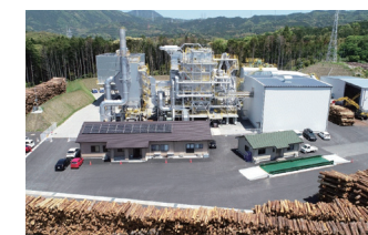
ふくおか木質バイオマス発電所
