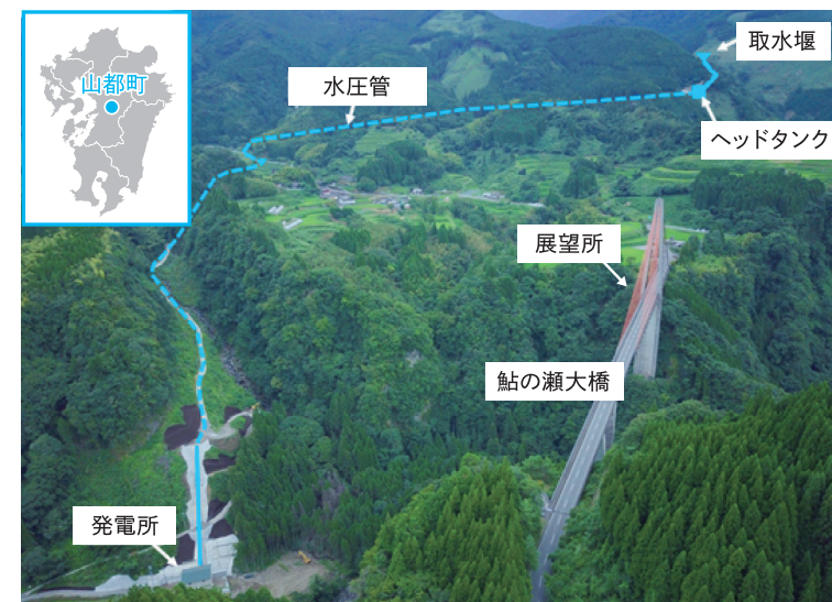
発電所の全景
