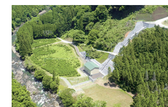
鴨猪水力発電所
