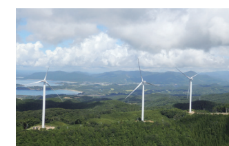
串間風力発電所
