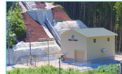
鴨猪水力発電所 1,990kW (2018年9月運転開始) 地域のかんがい用水路と未利用落差を有効活用
