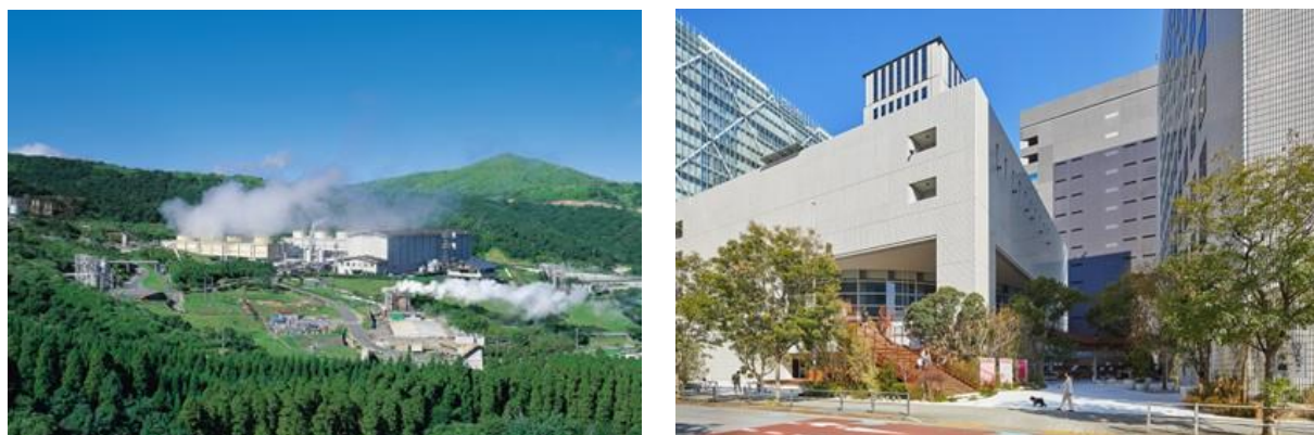
（左から）地熱発電所（九電みらいエナジー八丁原発電所）と供給先の「THE CAMPUS」
